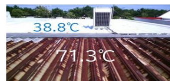
折板屋根断熱塗装あり・なし
