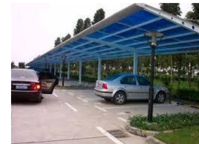
カーポートの紫外線劣化
