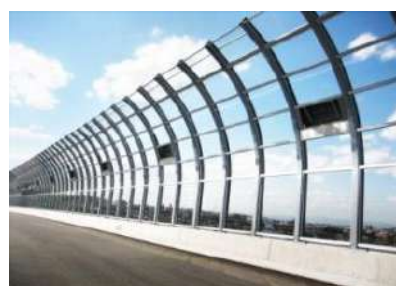
遮音壁・道路資材の樹脂板
